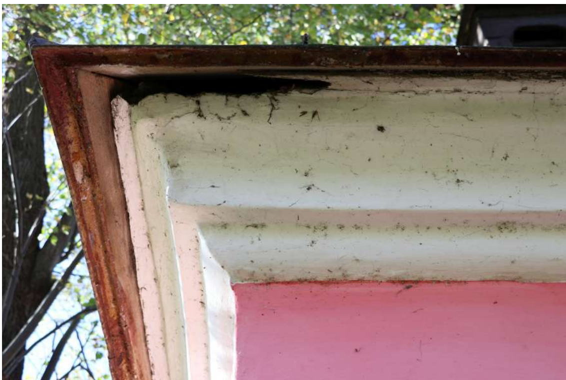
fot. 14: Kapliczka domkowa - widoczne zabrudzenia atmosferyczne gzymsu.
