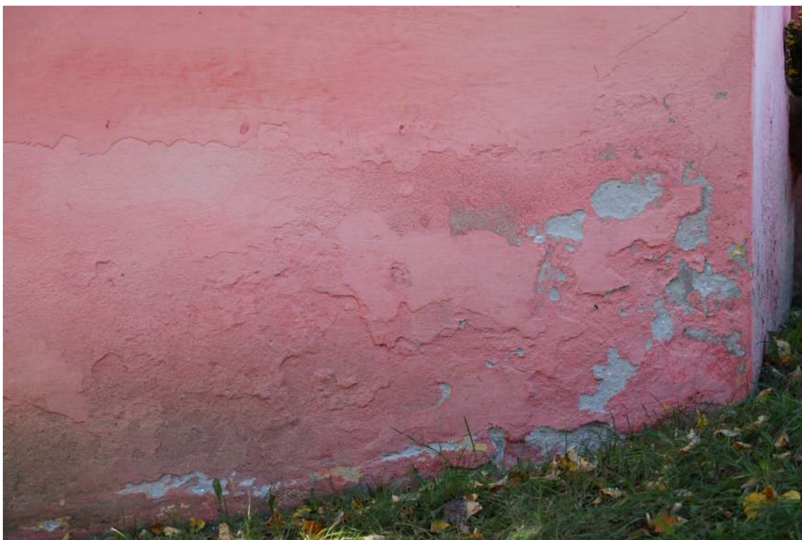
fot. 12: Kapliczka domkowa - widoczne odpryski farby na tynku elewacyjnym przy linii gruntu.
