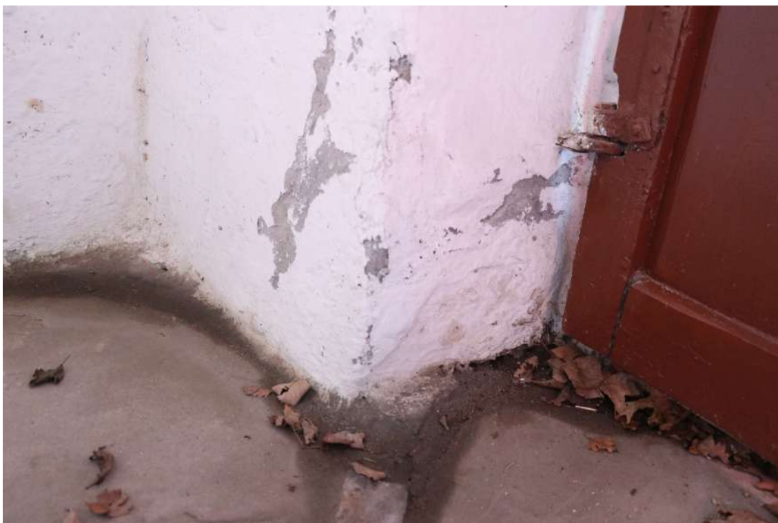
fot. 27: Kapliczka domkowa - widoczna odpadająca farba wierzchnia z powierzchni tynku.
