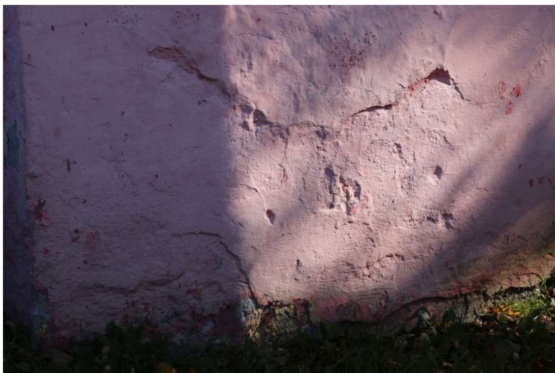
fot. 22: Kapliczka domkowa - widoczne nierówności i ubytki tynku elewacyjnego.
