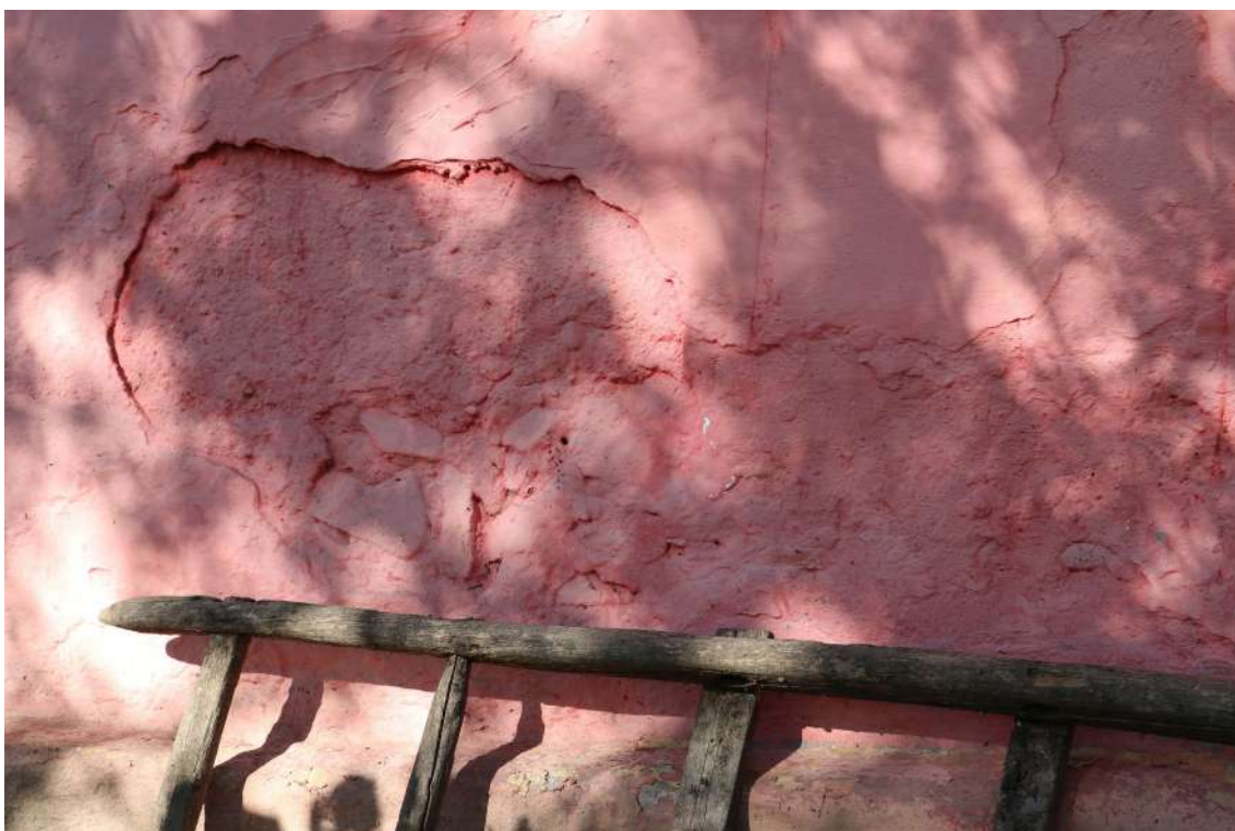
fot. 17: Kapliczka domkowa - widoczne ubytki tynku zamalowane farbą elewacyjną.
