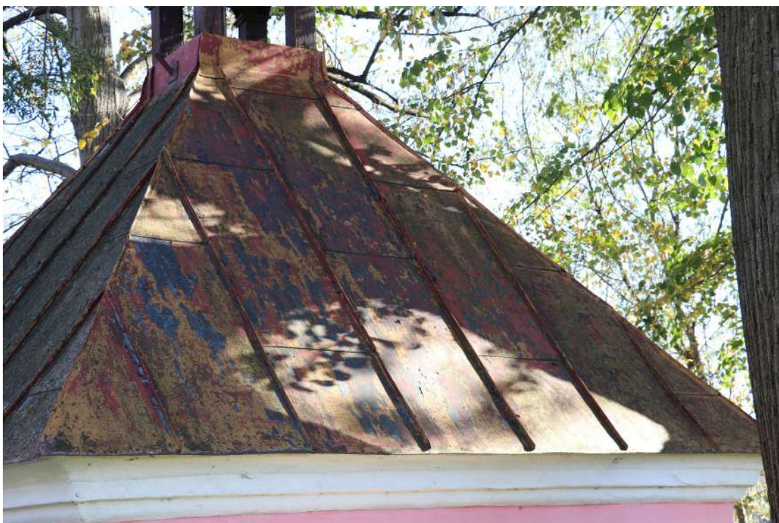
fot. 21: Kapliczka domkowa - pokrycie dachowe pokryte nalotem biologicznym z ubytkami farby wierzchniej.
