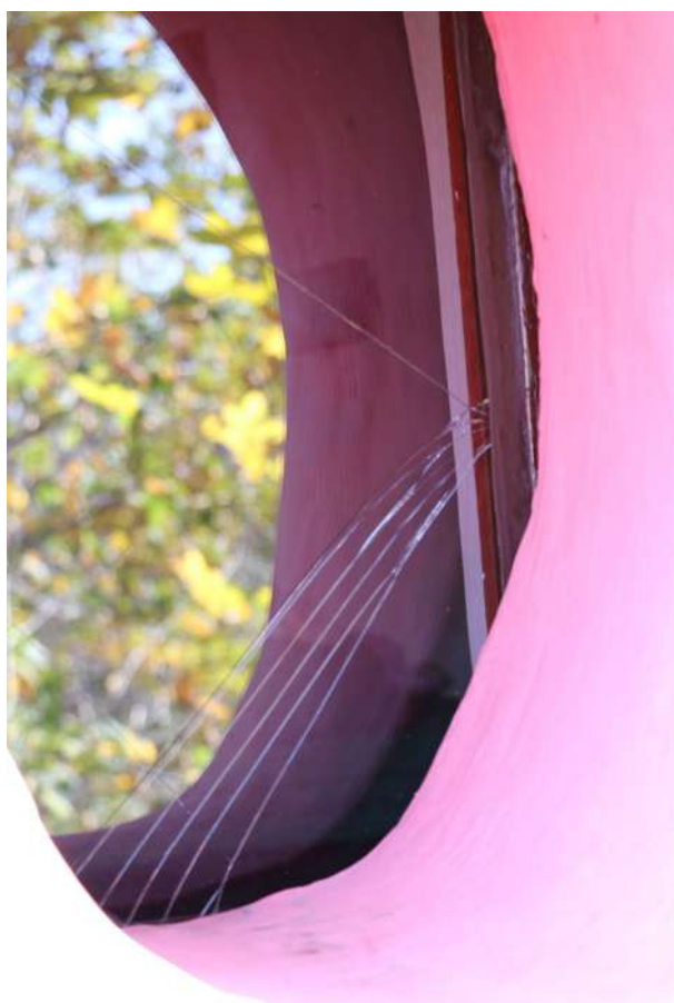
fot. 8: Kapliczka domkowa - widoczne pęknięcie szyby okienka kapliczki.
