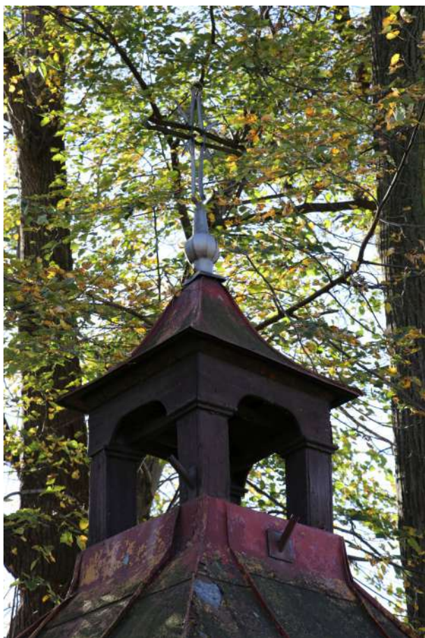
fot. 3: Kapliczka domkowa - widoczna sygnaturka pokryta nalotem biologicznym.
