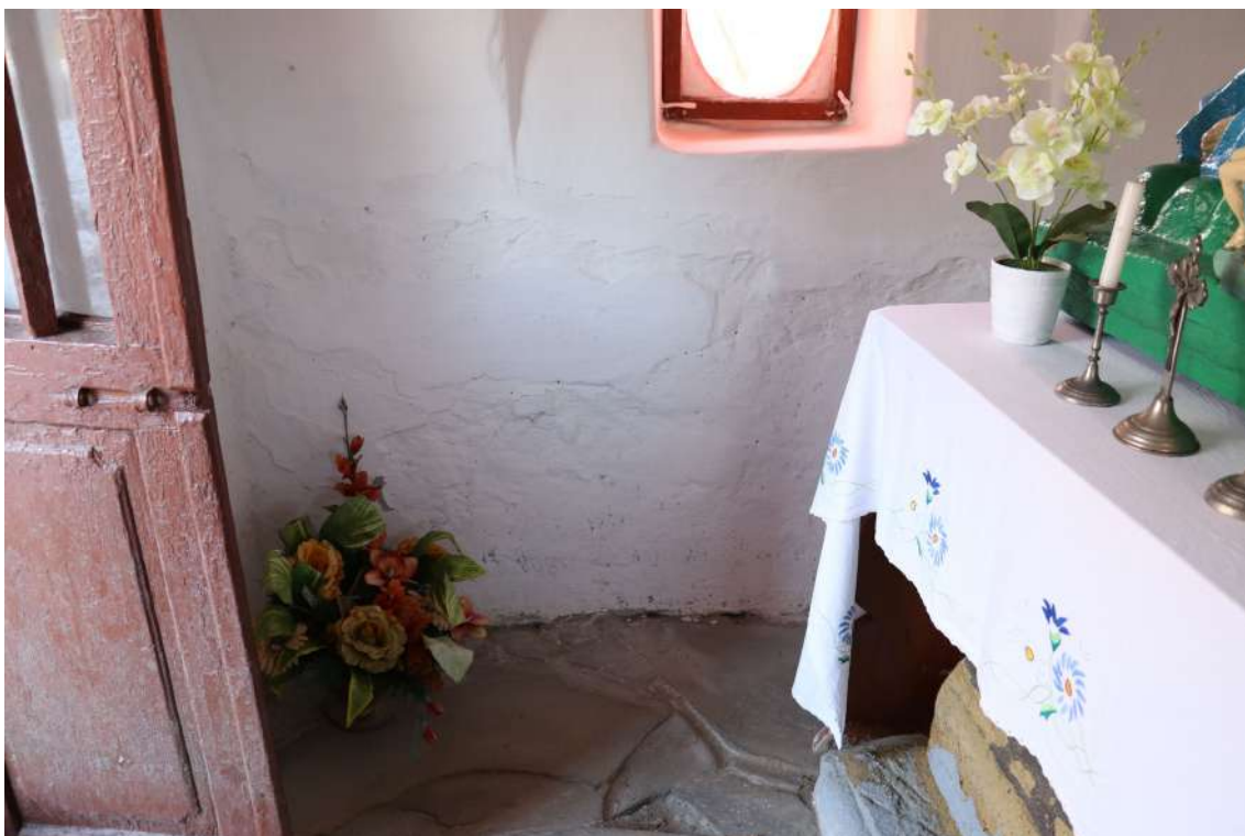
fot. 25: Kapliczka domkowa - widoczne wtórnie pomalowane białą farbą uszkodzenia i degradacje tynku ścian kapliczki.
