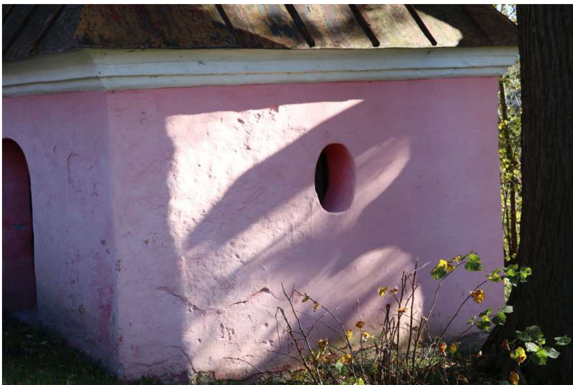
fot. 20: Kapliczka domkowa - widoczne nierówności tynku na elewacji bocznej kapliczki.
