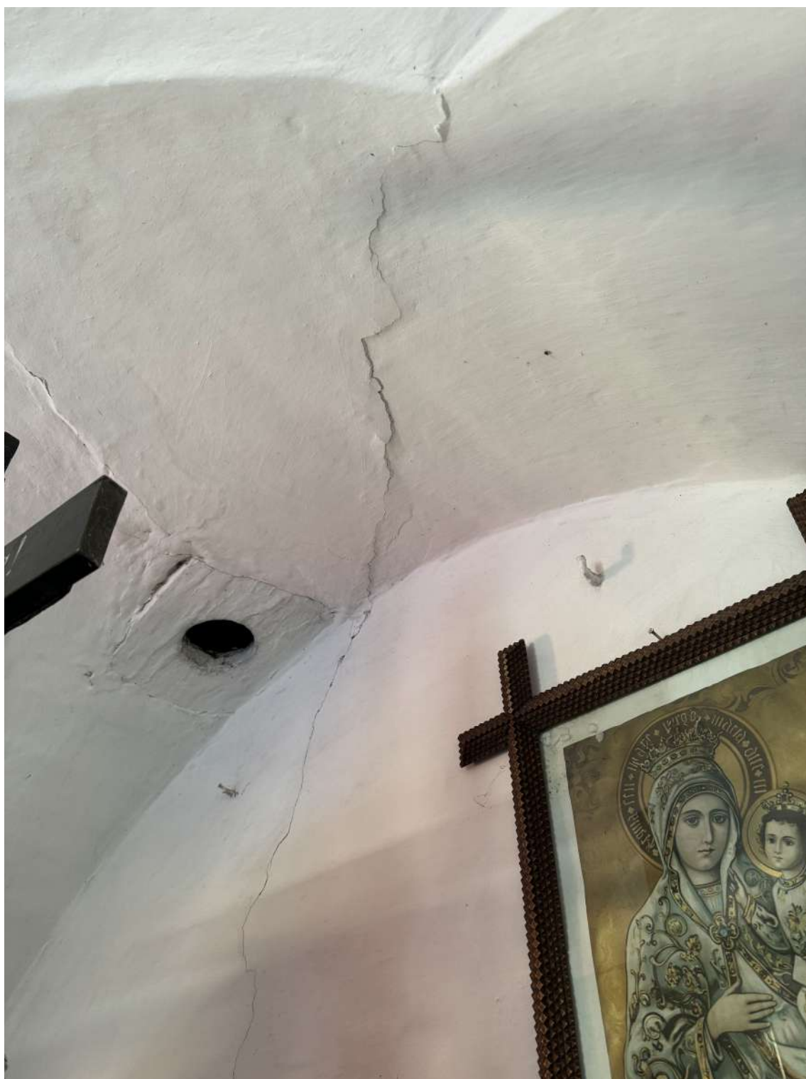
fot. 29: Kapliczka domkowa - widoczne pęknięcie na sklepieniu i ścianie tylnej kapliczki.
