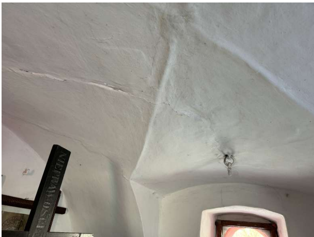
fot. 30: Kapliczka domkowa - widoczne wtórne uzupełnienie na wysklepkach sklepienia kapliczki.
