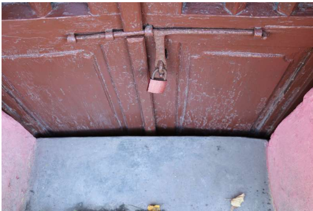
fot. 9: Kapliczka domkowa - widoczne uszkodzenia farby olejnej drzwi wejściowych kapliczki.
